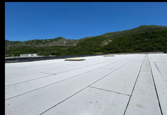
San Pellegrino Terme (BG) Rifacimento con membrane bituminose Mq 2.650,00
