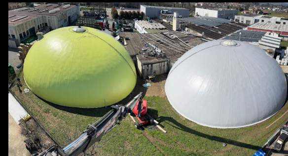
Isola Vicentina (VI) Rifacimento con membrane sintetiche in PVC Mq 3.900,00
