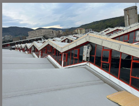
Trieste (TS) Rifacimento con membrane bituminose Mq 13.200,00
