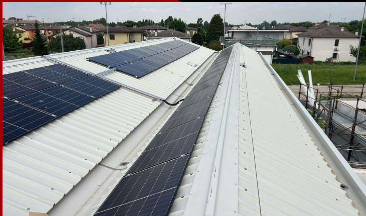
Villa Bartolomea (VR) Posa pannelli sandwich per fotovoltaico Mq 450,00
